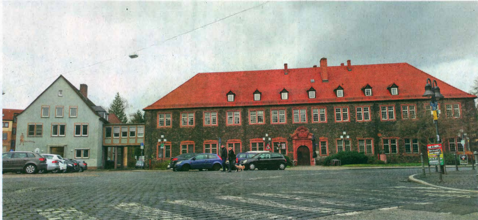
Hier sollen ab Herbst 2020 die Bagger rollen: Baugesellschaft und Terramag gestalten das Areal am Schlossplatz neu.
